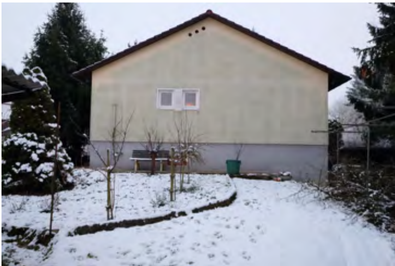
Bild 2: Wohnhaus, Garten nach Norden
