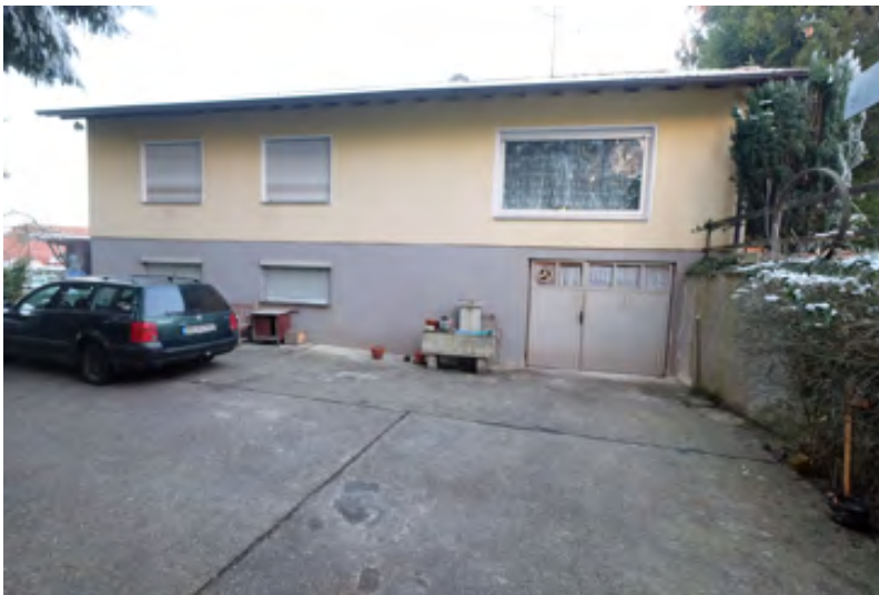
Bild 3: Wohnhaus, Hof, Garage im Untergeschoss
